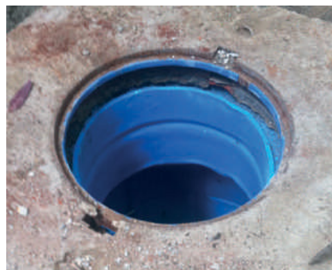
FINALIZAÇÃO DA INSTALAÇÃO
